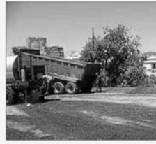
Obras de asfaltado.
