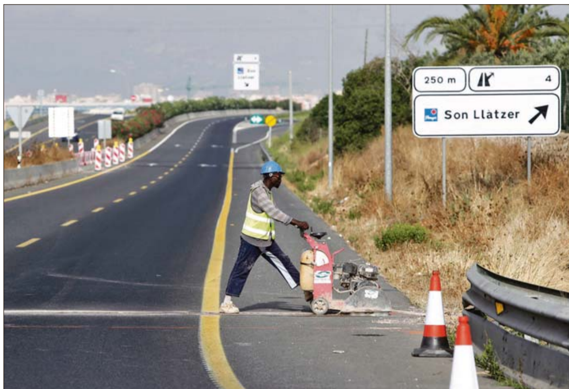
Un operario trabaja en obras de la carretera de Manacor junto a la salida de Son Llätzer. MANU MIELNIEZUK
