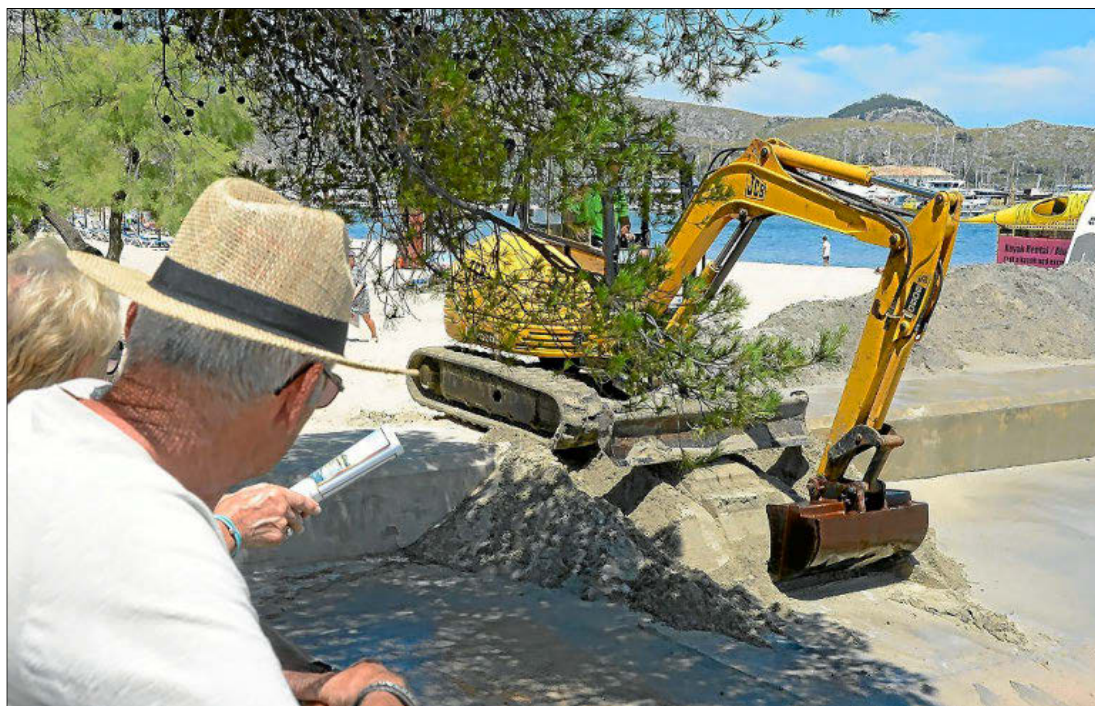
Obras en el Port de Pollença. JORDI AVELLA
