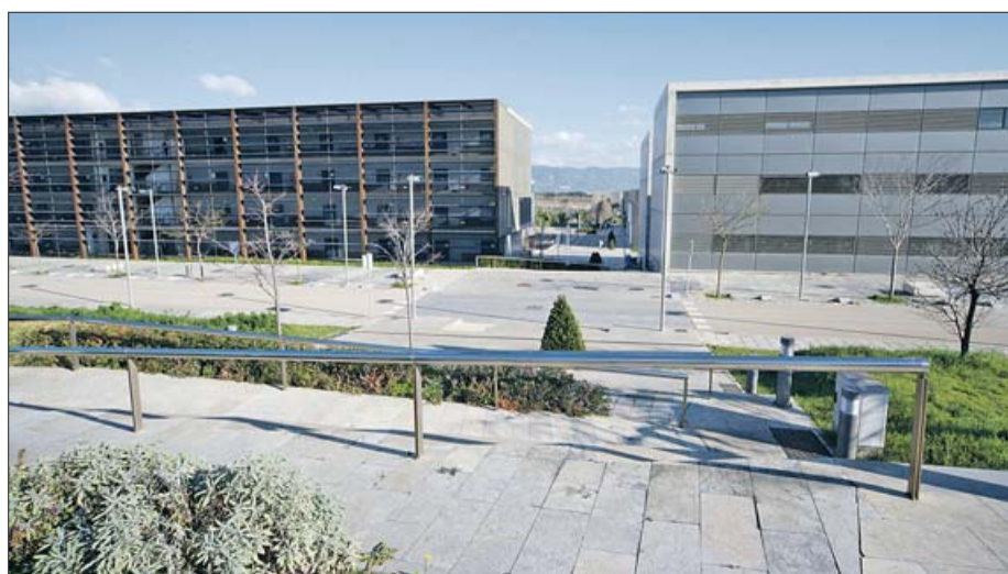
Vista de las instalaciones del Parque Balear de Innovación Tecnológica. PARC BIT
